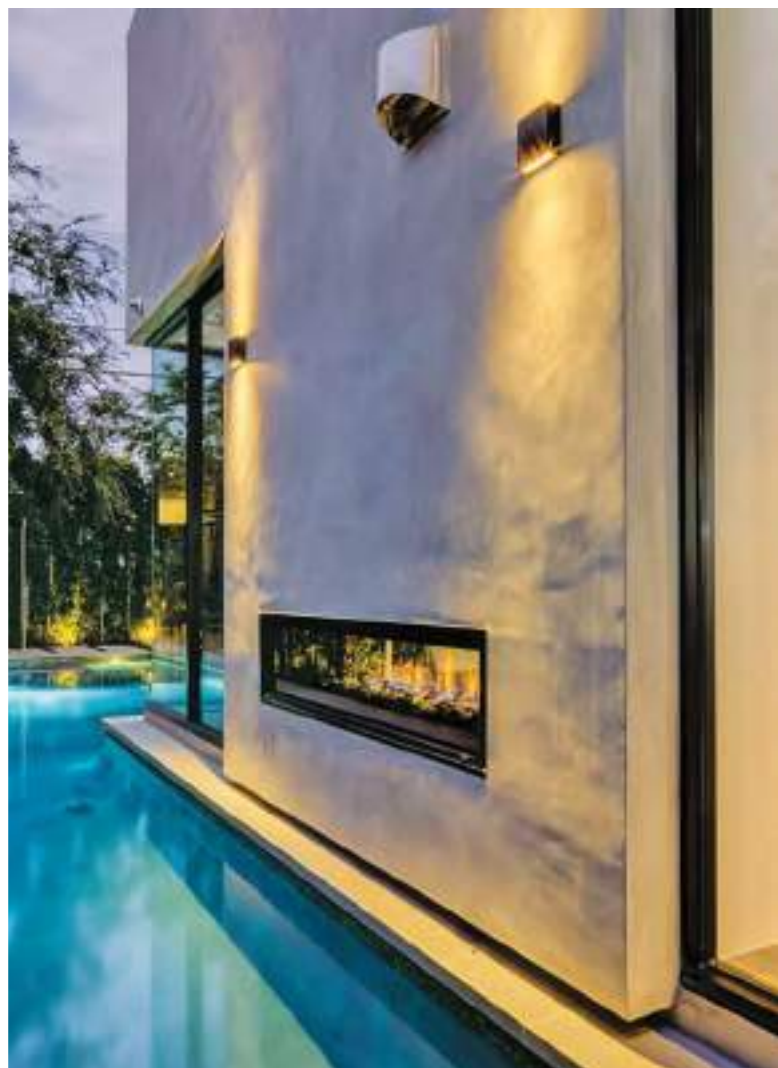
Systémový rám pre vsadenie priehľadovej plynovej krbovej vložky do obvodovej steny medzi interiér a exteriér.
