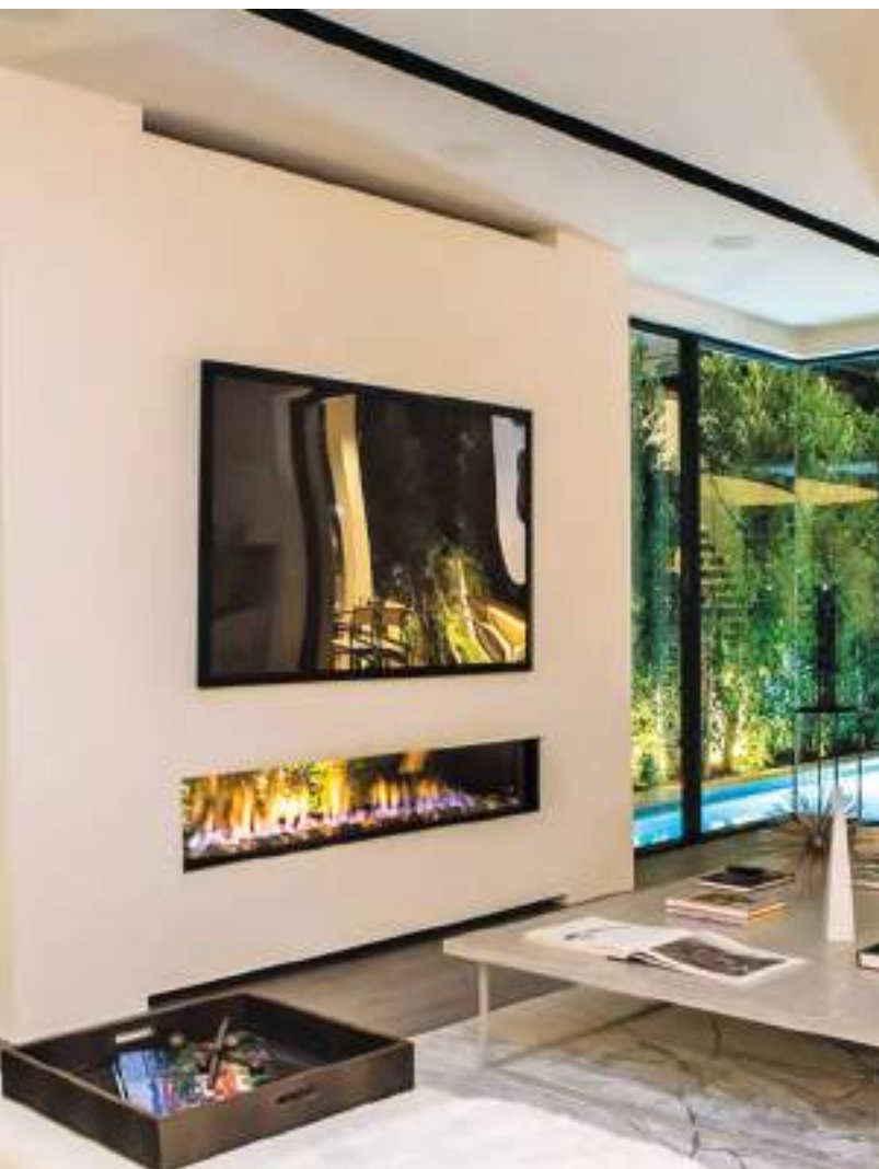
Systémový rám pre vsadenie priehľadovej plynovej krbovej vložky do obvodovej steny medzi interiér a exteriér.
